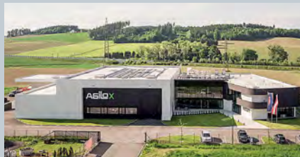
BÜROS, MONTAGEHALLE, LAGER: Für den Roboter-Hersteller Agilox realisierte Peneder 2024 bereits die zweite Ausbaustufe seines neuen Headquartiers.
